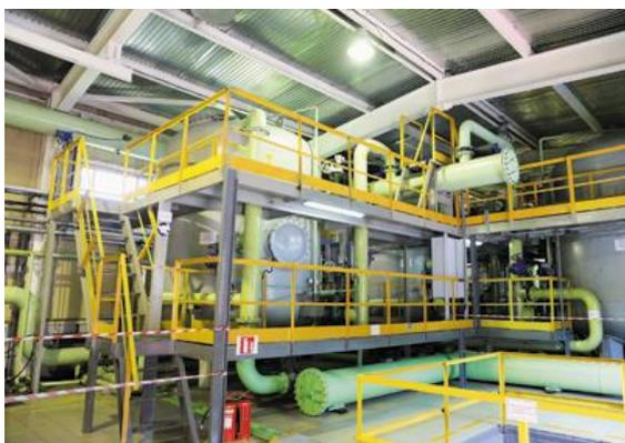
Водоочистные сооружения ш. Распадская-Коксовая. Двухкамерный фильтр ФОВ -2К
