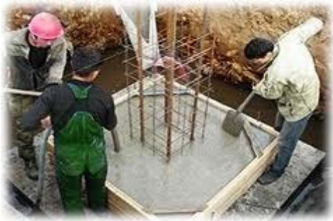
Рис. 3.6. Бетонирование
