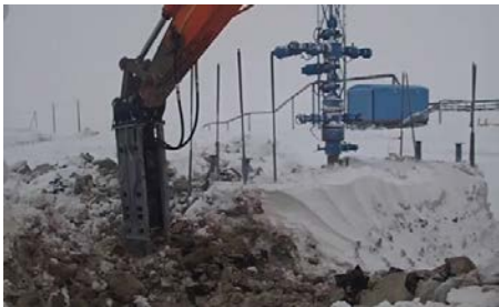
д) одноковшовый экскаватор, оборудованный гидромолотом
