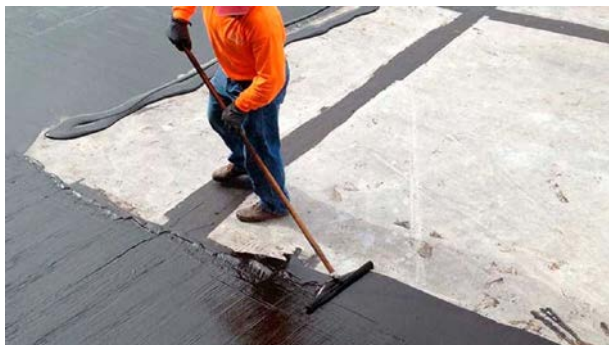
Рис.3.25. Огрунтовка праймером поверхности кровли
