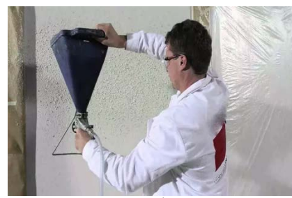
Нанесение флокового покрытия
